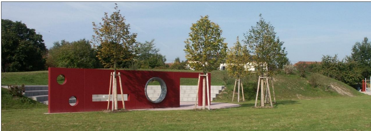
Abbildung 29: Kies-Wasser Erdbecken in Eggenstein. Bildquelle: Universität Stuttgart, Institut für Gebäudeenergetik, Thermotechnik und Energiespeicherung.
